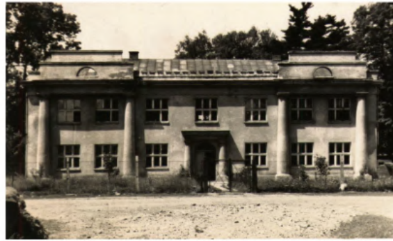
Budynek szkoły w Harmężach, lata 50. XX wieku. Fot. Archiwum ZSP Harmęże
