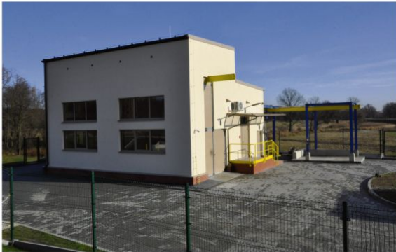
Wybudowana w Pławach pompownia jest elementem kompleksowego systemu ochrony przeciwpowodziowej. Fot. LCH
