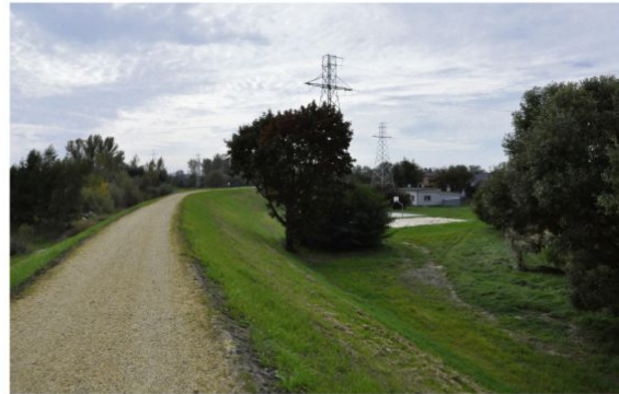
Zmodernizowany wał Soły w Broszkowicach. Fot. LCH
